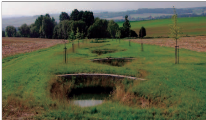
Stav po dokončení stavby jaro 2015 (celkový pohled)
