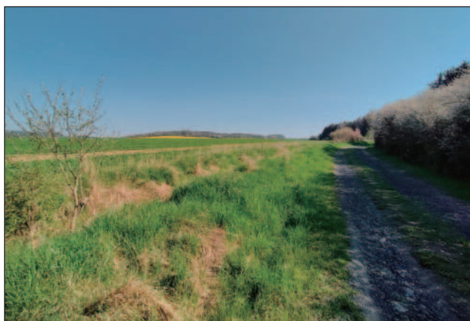
Obr. 16, 17, 18 – Nově vybudované polní cesty
