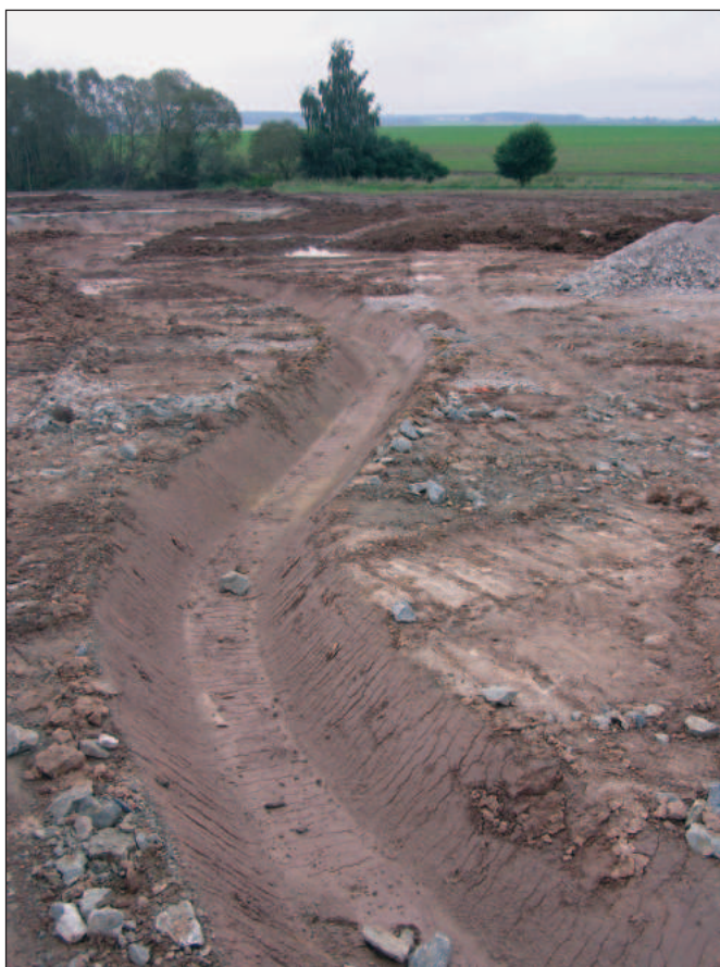
Povrchový příkop spojující jámy
